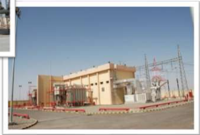
Wadi Sa'a 132/33 KV GIS Substation
